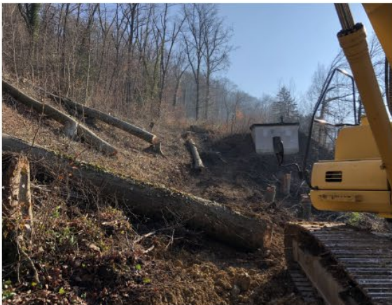
Abbruch ehem. Hollen 2, © MerNatur GmbH
