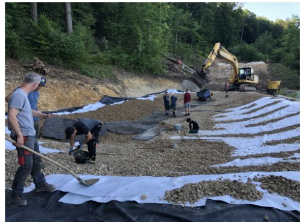
Bauarbeiten Weiher, © MerNatur GmbH
